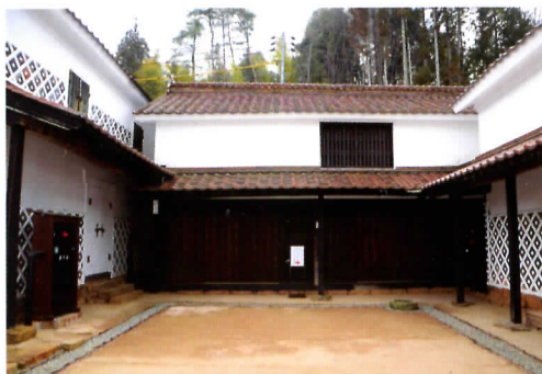
付属建物の外観
